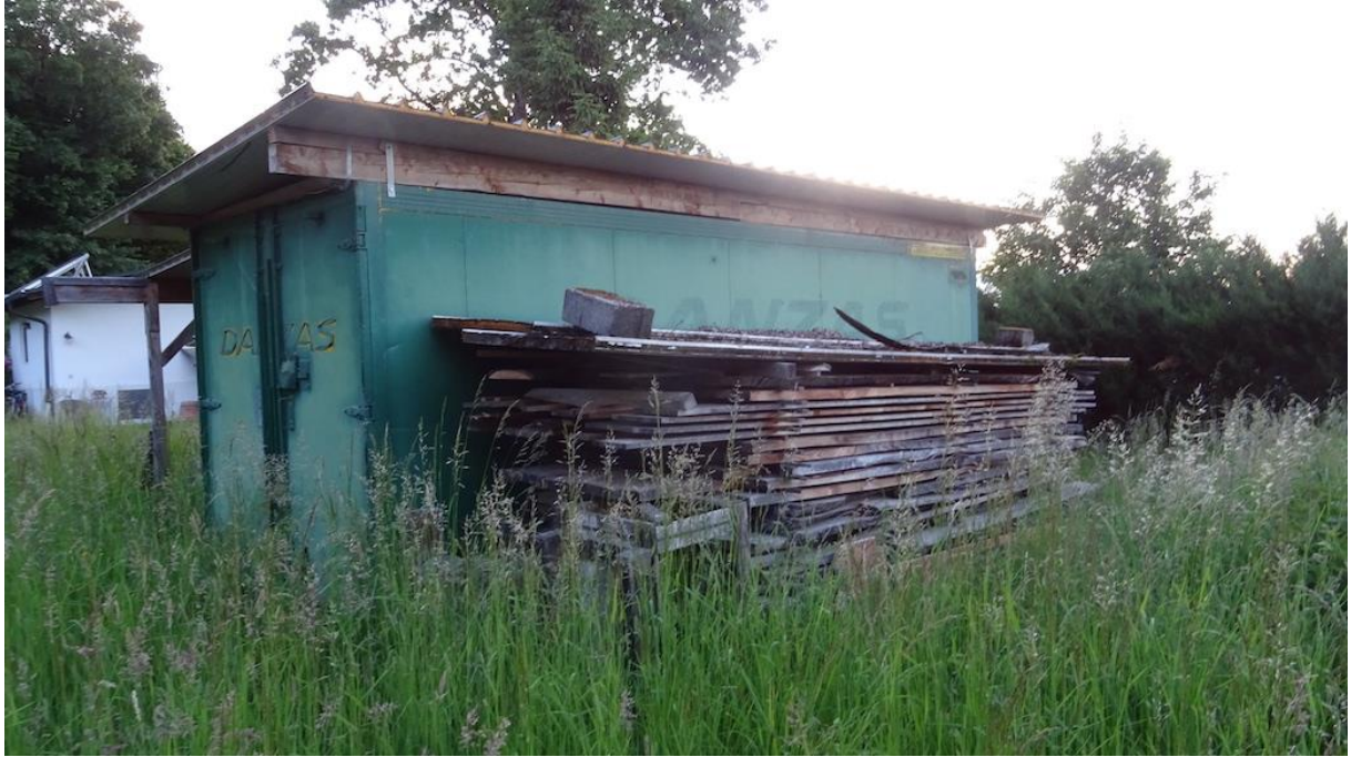
Abb. 8: Gelagerte Holzbretter am nördlichen Containerschuppen (Foto: B. Pfeiffer).
