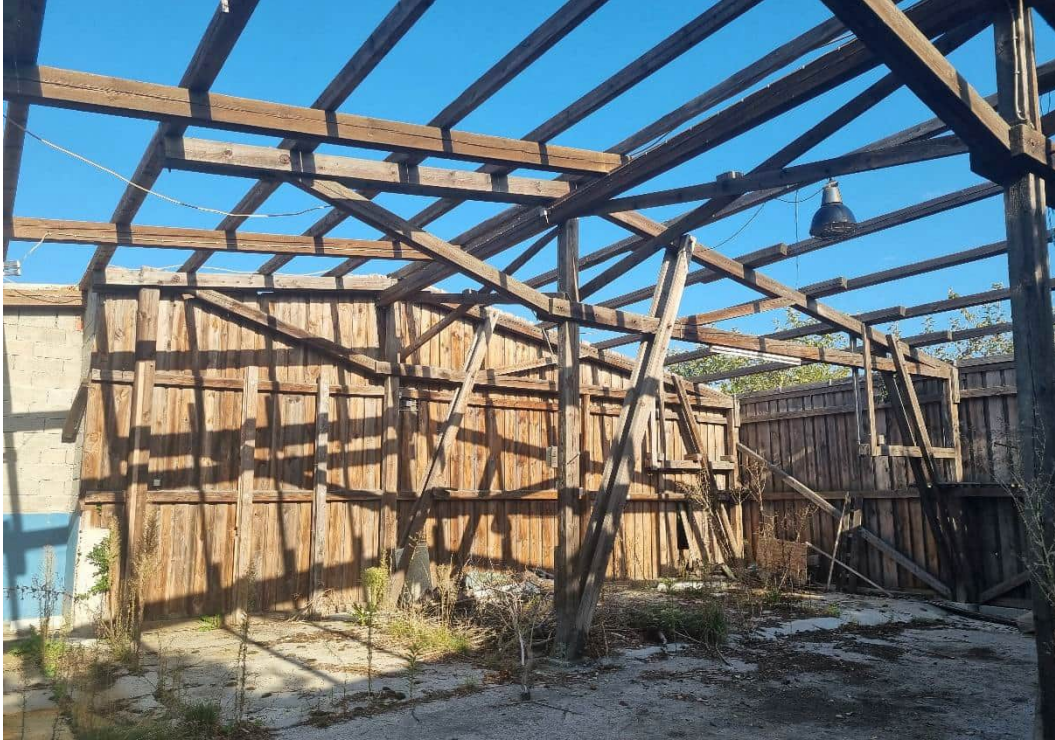
Abbildung 18: Gebäudekonstruktion aus Holz im Nordosten des UG. Stand 08.09.2024
