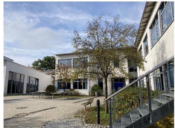
Gebäudefassade Richtung Innenhof, Foto 16.10.24
