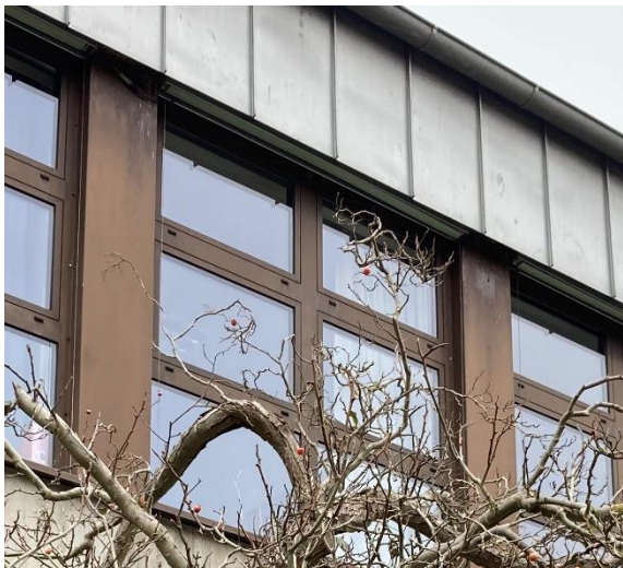
Fassade Mit Brutnische zwischen Rollokästen (Abrissgebäude), Foto 16.10.24
