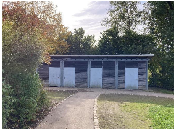
Nebengebäude mit möglichen Brutplätzen unter Dach, Foto 16.10.24
