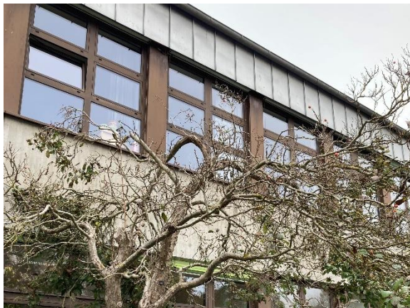
Gebäudefassade Richtung Adolf-Rebl Str. Foto 16.10.24
