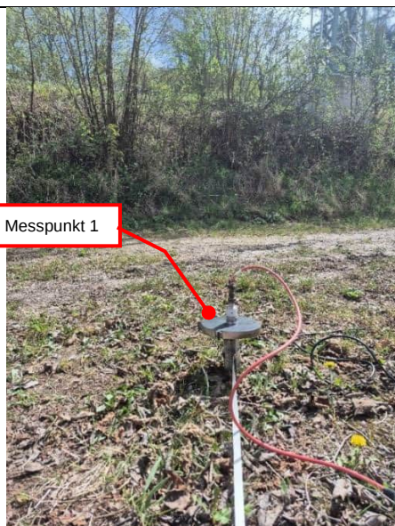
Abbildung 6: Nahaufnahme Messsensor (MP1) im Gelände (12-m-Punkt); Aufnahme in Richtung Bahntrasse
