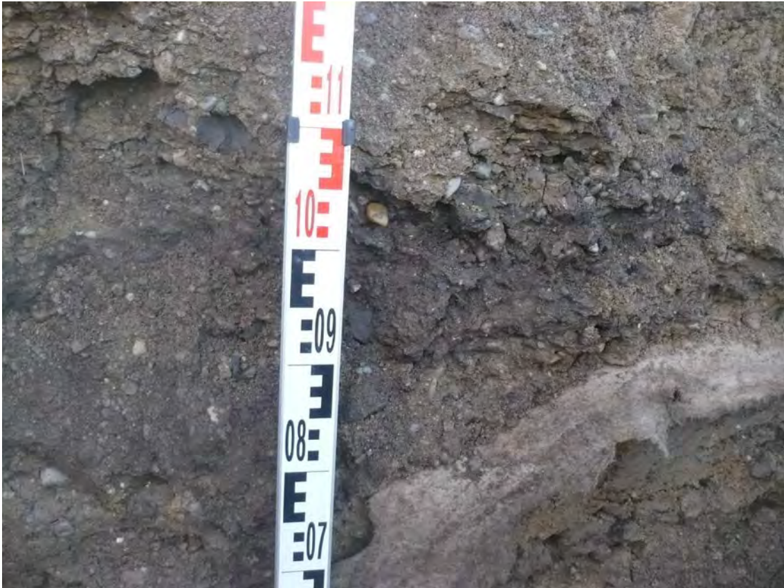
Abb 7: Schurf PS 5 (Detail) mit auffälliger Schicht und Flieslage.
