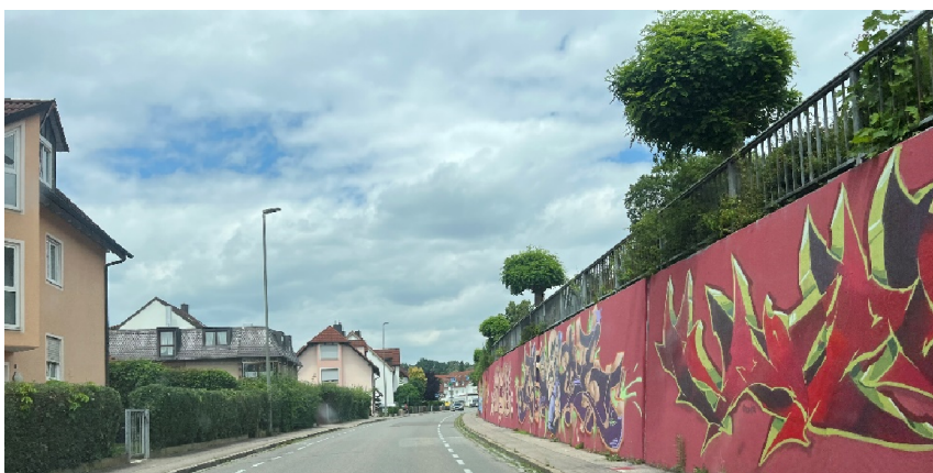
Abbildung 1 Stützwand an der Nordseite der Hohenwarter Straße
