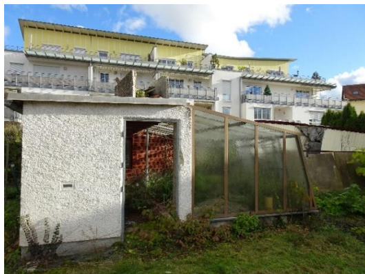
Abbildung 15: Gewächshaus im östlichen Teil des Grundstücks an der Joseph-Maria-Lutz Straße (Foto: WipflerPLAN Nov. 2022)
