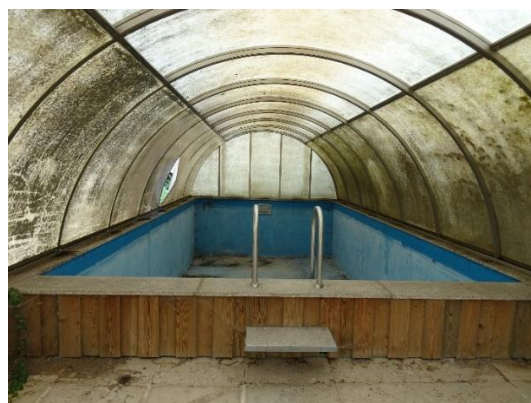
Abbildung 18: Poolhaus im südöstlichen Bereich des Grundstücks (Foto: WipflerPLAN Nov. 2022)
