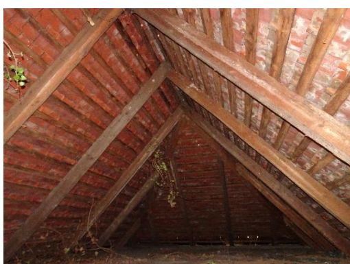
Abbildung 11: Dachboden des Nebengebäudes (Foto: Wipfler PLAN Nov. 2022)
