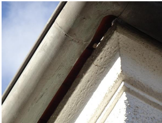
Abbildung 7: Bereich zwischen Hauswand und Dach am Wohngebäude (Foto: Wipfler PLAN 2022)
