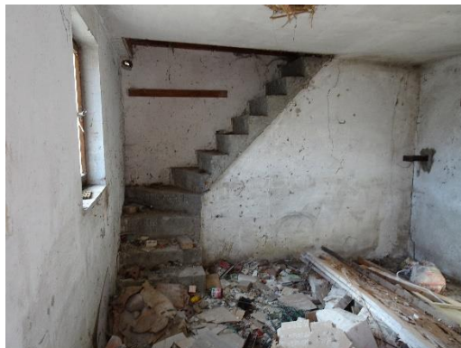
Abbildung 10: Größerer Raum im Nebengebäude auf der rechten Seite (Foto: WipflerPLAN Nov. 2022)
