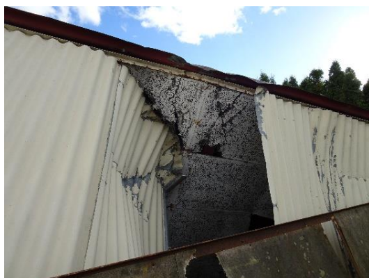
Abbildung 19: Wellblechhaufen der ehemaligen Garage in der südöstlichen Ecke des Grundstücks (Foto: Wipfler PLAN Nov. 2022)
