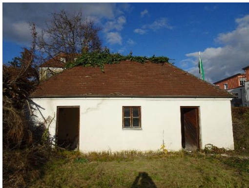
Abbildung 9: Nebengebäude an der nordöstlichen Grundstücksgrenze (Foto: WipflerPLAN Nov. 2022)
