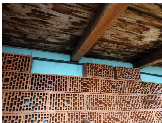
Abbildung 17: Ziegelverkleidung im Inneren westlichen Teil des Gewächshauses (Foto: WipflerPLAN Nov. 2022)
